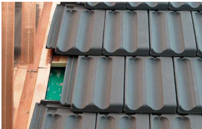
Der Gettnauer Muldenziegel M36 braun wird für die sechs Mehrfamilienhäuser in Ossingen verschränkt eingedeckt.
