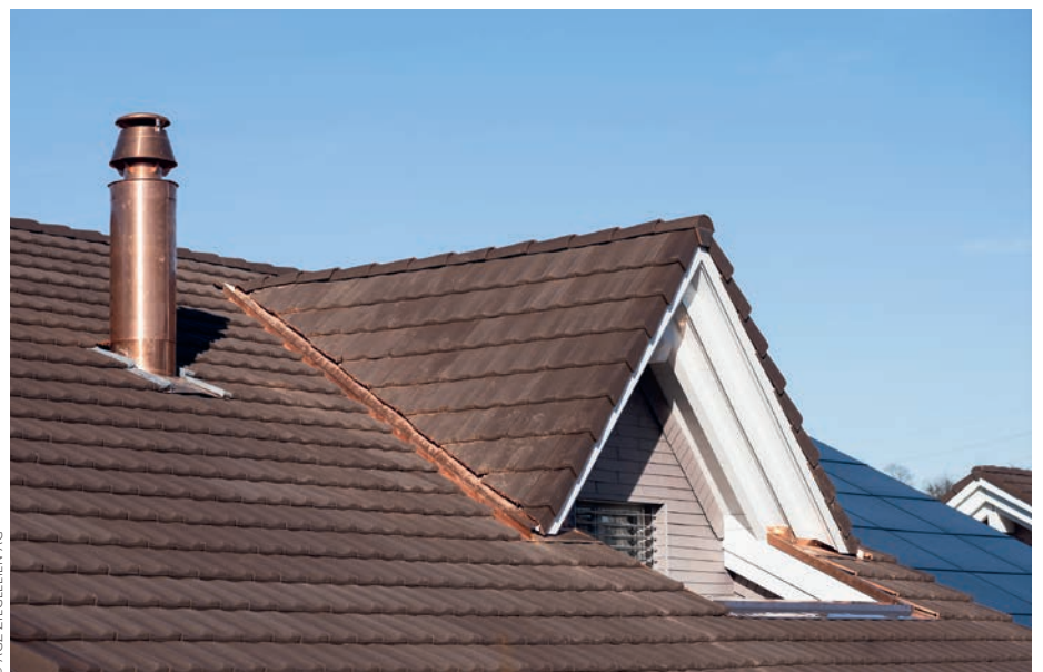
In neuem Glanz: Das fertig eingedeckte Haus mit dem FS37 Flachschiebeziegel, dem meistverwendeten Tondachziegel der Schweizer Traditionsfirma AGZ Ziegeleien AG.
