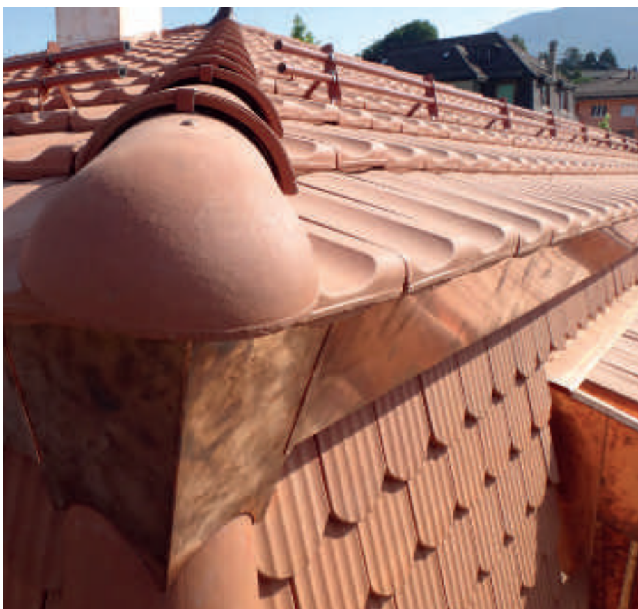
Das Dach wurde mit naturroten Ziegeln neu eingedeckt.
