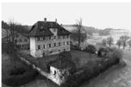
Schloss im Dornröschenschlaf, Zustand Februar 2002, Flugaufnahme von Südosten
