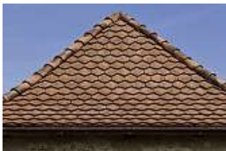
Gettnauer Biber mit vier unterschiedlichen Spitzausprägungen
